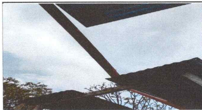
SUSTITUCION DE TUBOS FLUBIALES
