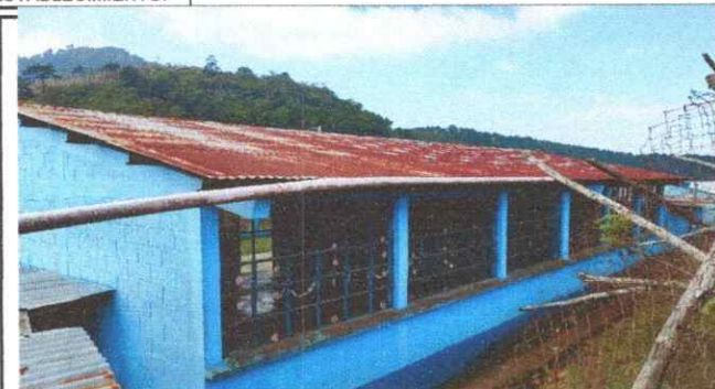
SUSTITUCION DE PINTURA
