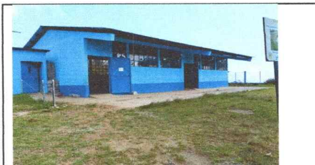
SUSTITUCION DE PINTURA INTERIOR EXTERIOR
