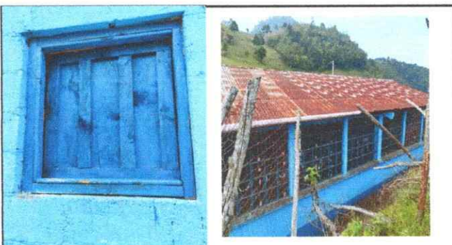
SUSTITUCION DE VENTANAS A BALCONES
